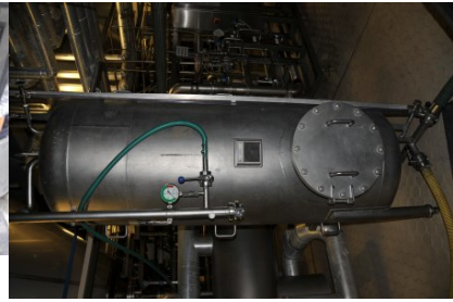
Legalizacja instalacji za pomocą kolby podciśnieniem
