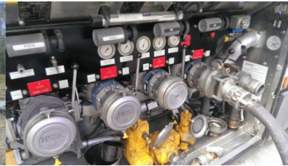
Instalacja pomiarowa na cysternie samochodowej
