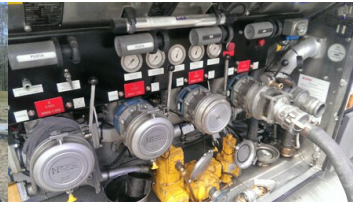
Instalacja pomiarowa na cysternie samochodowej
